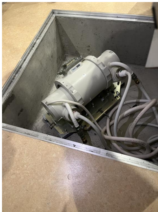
埋在地下用於治療定位的 X 光球管
